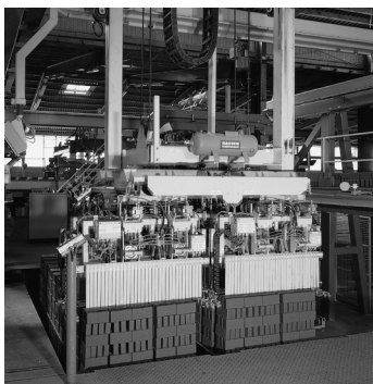
Шланги и компенсаторы из нержавеющей стали на печи для отжига кирпича
